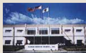
Hitachi Air Conditioning, Филиппины
